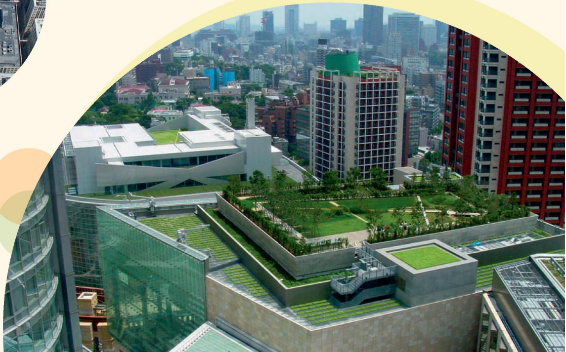
Prédios em áreas fechadas pobres em biodiversidade (esquerda) Teto e fachada verdes promovem a biodiversidade (direita)
