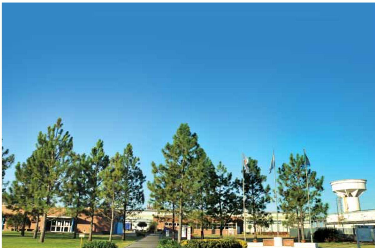
Acceso principal Planta de Agroquímicos de Zárate
