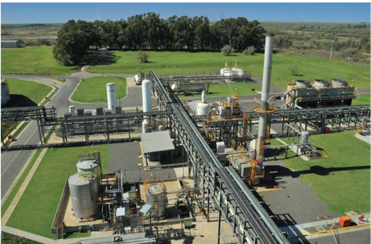
Planta de Manufactura de Agroquímicos en Zárate
