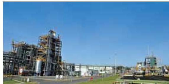
Planta de Manufactura de Agroquímicos en Zárate
